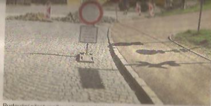
Budování přestupního uzlu nádraží Nepomuk
